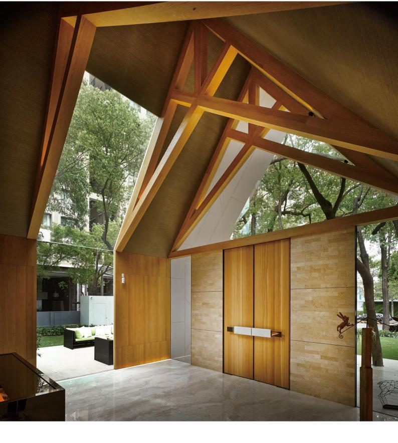
刻意將木製桁架外露的尖頂建築,有種引人合掌仰望的崇敬之意,選用香柏打造大門,上半部的桁架與兩側鑲嵌玻璃,以及入內後側向的建築體取屋簷斜面的 2/3 到正立面,皆以大片玻璃鑲嵌,順勢導入充沛天然光與樹影。
